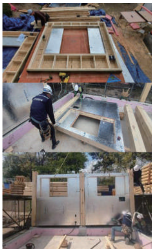
프리캐스트 일체형 벽체 시공
