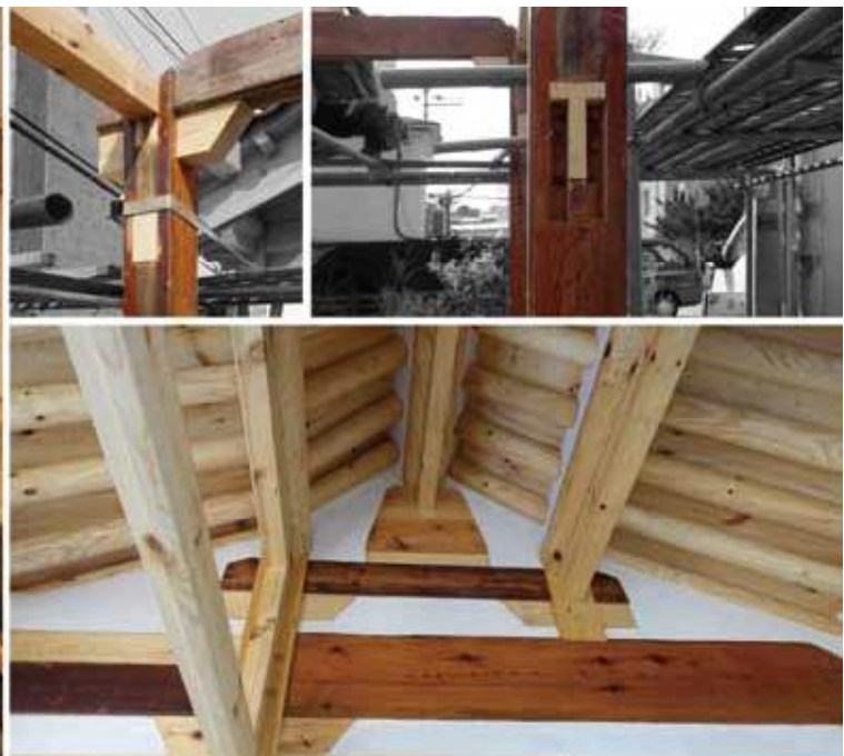
기존 한옥의 대량과 종량이 인체 대청에 재사용된 모습
