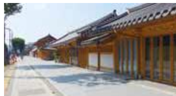
가로와의 연속성 · 장안문~팔달문을 잇는 정조대로와 축 대응 · 정, 배면의 폴딩도어 개방 시 가로와 내부공간의 통합
