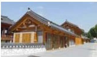
기존 한옥시설 매스와 조화 · 크고 작은 매스를 분절시켜 배치 · 모서리 공간을 비워 개방성 확보
